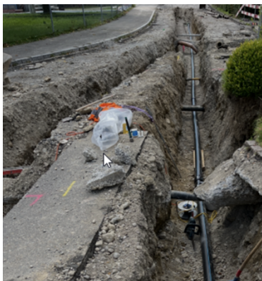
Rohrlegearbeiten Poststrasse. Raphael Baumann
